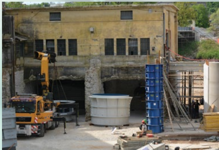
MONTAŽA VBETONIRANIH DELOV TURBINE
