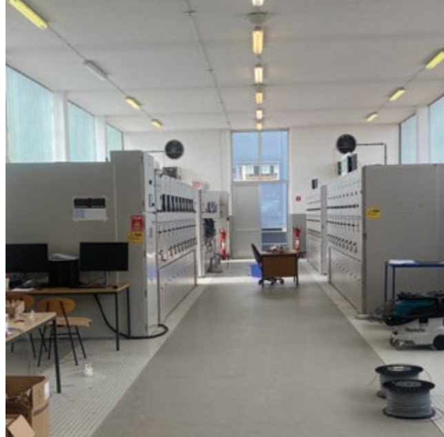
REKONSTRUKCIJA SISTEMA ZAŠČITE IN VODENJA 20-KILOVOLTNEGA DELA STIKALIŠČA POTEKA PO FAZAH
