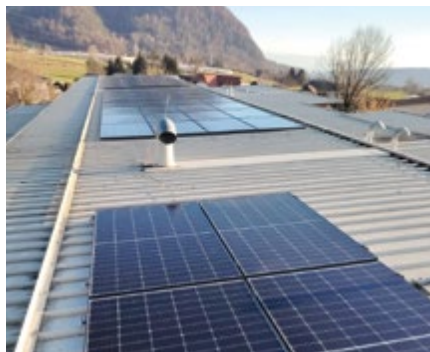
POSTAVljena SONČNA ELEKTRARNA NA STREHI VRTCA PIRNIČE
