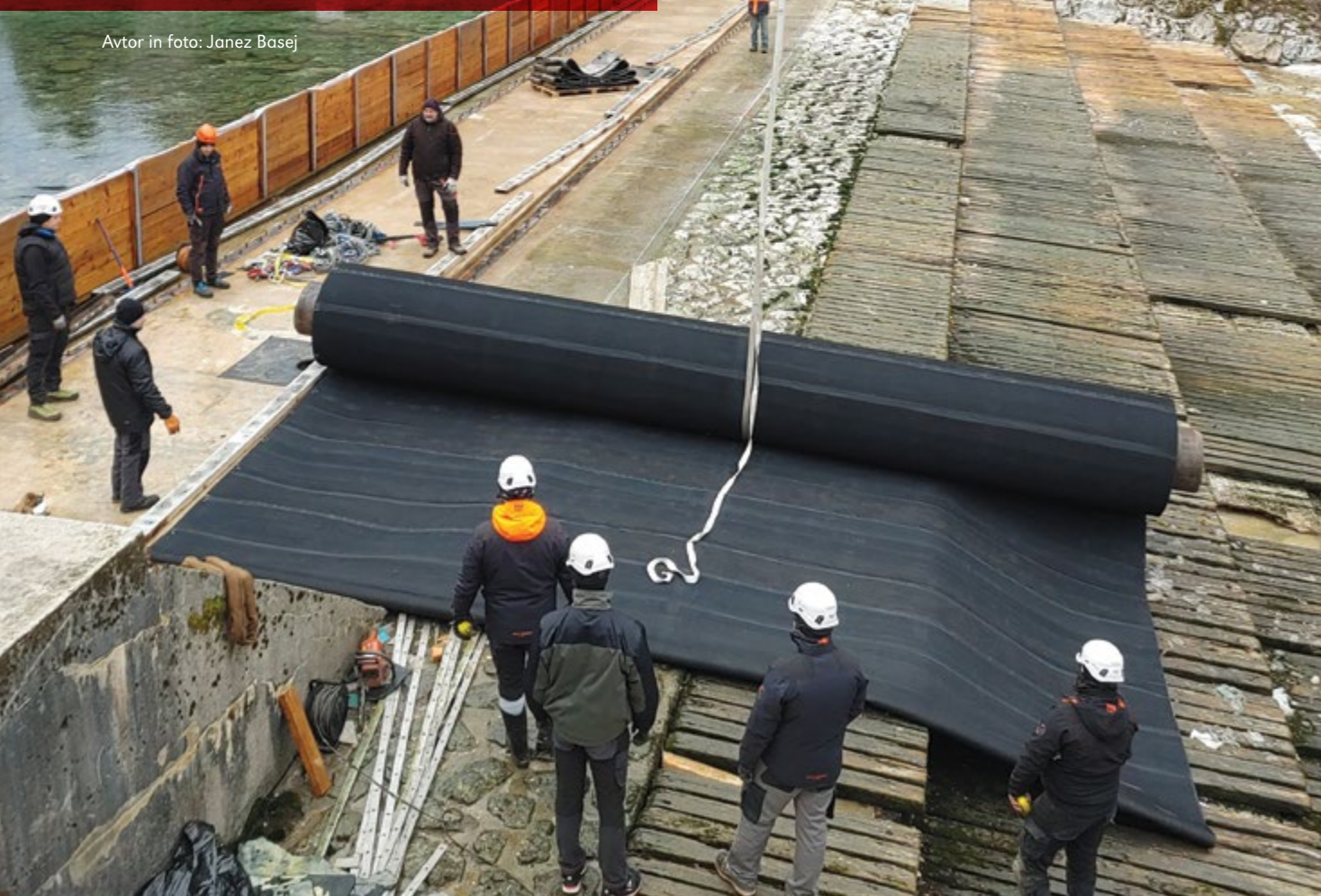
MONTAŽA NOVE GUMENE MEMBRANE
