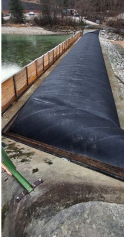
POSKUSNO POLNLENJE MEMBRANE IN TEST TESNOSTI
