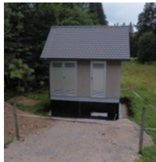
OB POČIVALIŠČU JEPRCA SE GRADI NOVA NADOMESTNA TRANSFORMATORSKA POSTAJA S STREHO DVOKAPNICO
