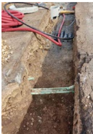
IZVEDBE VEČČEVNE KABELSKE KANALIZACIJE
