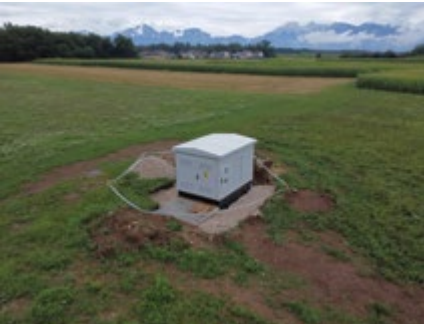
TP KANU BO ZGRAJENA KOT KOMPAKTNA PLOČEVINASTA TRANSFORMATORSKA POSTAJA
