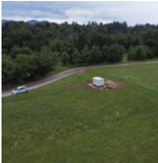
TP KANU BO ZGRAJENA KOT KOMPAKTNA PLOČEVINASTA TRANSFORMATORSKA POSTAJA
