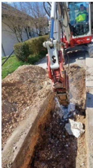
IZKOP KANALA V CESTI
