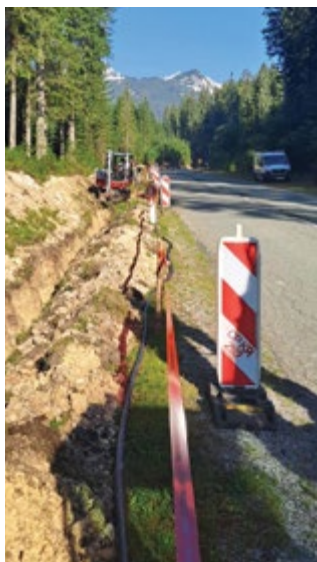
GRADNJA 20 KV KABLOVODA TP RUDNO POLJE–TP POKLJUKA
